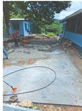
Foto 6: Mejoramiento de losa de patio
