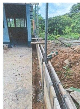
Foto 4: Mejoramiento de muro perimetral
