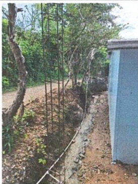
Foto 1: Mejoramiento de muro preimetral para el resguardo de los estudiantes.
