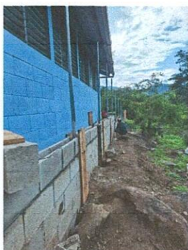
Foto 3: Lado izquierdo del establecimiento para mejoramiento de muro perimetral,
